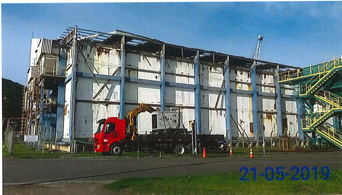
Figura 06 – Situação atual da edificação que terá suas telhas removidas
