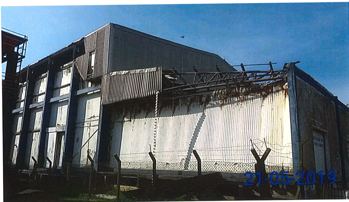
Figura 04 – Situação atual da edificação que terá suas telhas removidas
