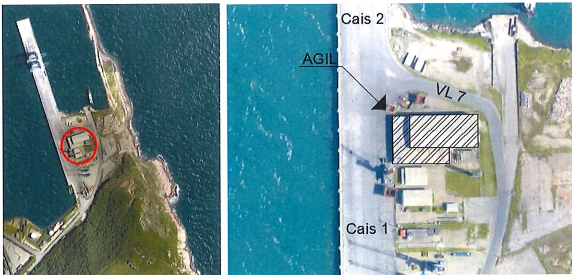
Figura 02 – Localização da edificação
