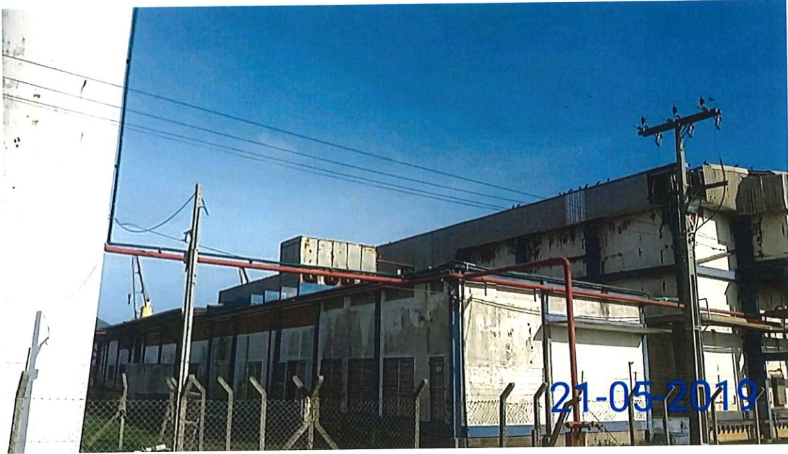
Figura 03 – Situação atual da edificação que terá suas telhas removidas
