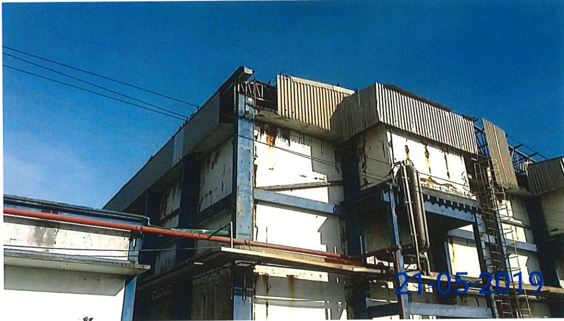
Figura 05 – Situação atual da edificação que terá suas telhas removidas
